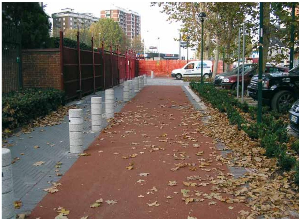
*Il warm mixed asphalt è una pavimentazione a base di bitume che, per la durezza e la colorazione, può essere utilizzata idealmente per le piste ciclabili e le aree destinate ad arredo urbano*
